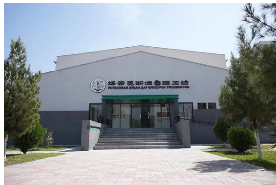
塔吉克斯坦鲁班工坊外观
