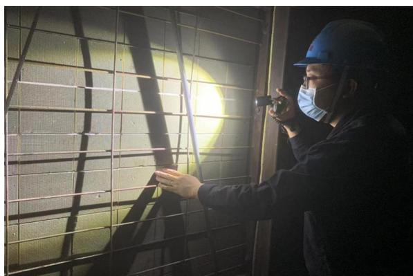
陈塘热电公司一套机组扩大性检修，生技部锅炉专业工程师宋适检查余热锅炉炉膛脱硝催化剂
