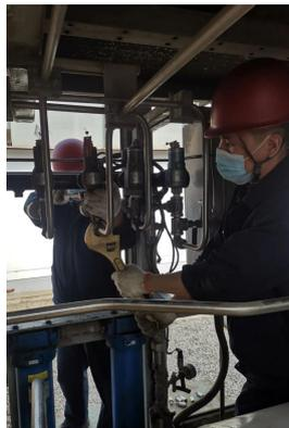
滨海燃气集团塘沽燃气公司运行班长王春东、运行人员柳泳旭维护压缩机安全阀
