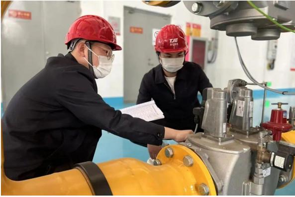
津安热电公司北辰供热服务中心工作人员刘哲先、刘东巡检锅炉燃烧器阀组、燃气管线及附属设备
