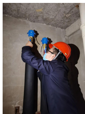
供热前夕，津安热电公司南开供热服务中心工作人员到平祥小区检查排气效果
